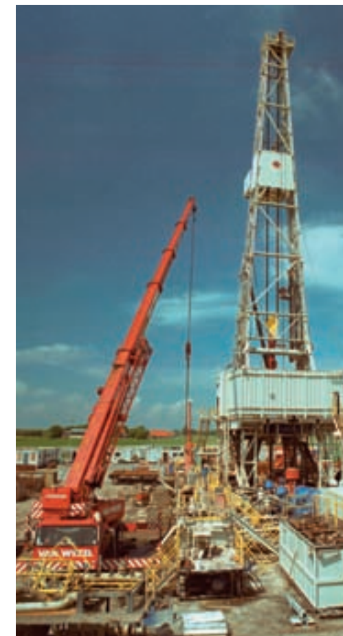
Anfang 2004 begannen bei der Frisia Zout die Arbeiten für eine zweite, aufwändige Kavernenbohrung, die innerhalb weniger Monate fertig gestellt wurde.
