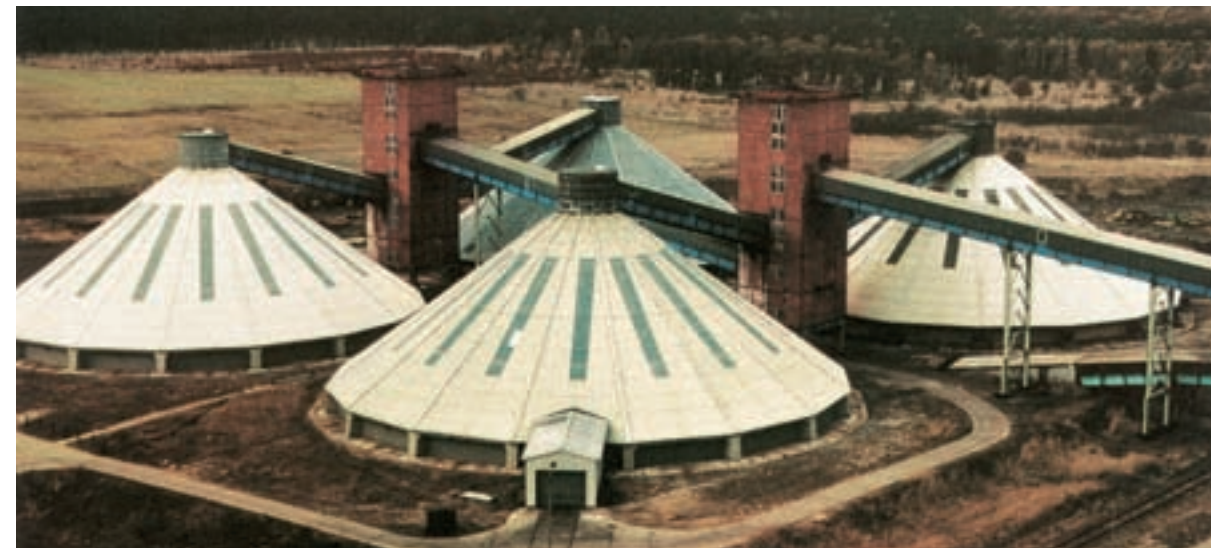
Die Rundschuppen im neuen Kaliwerk Zielitz
