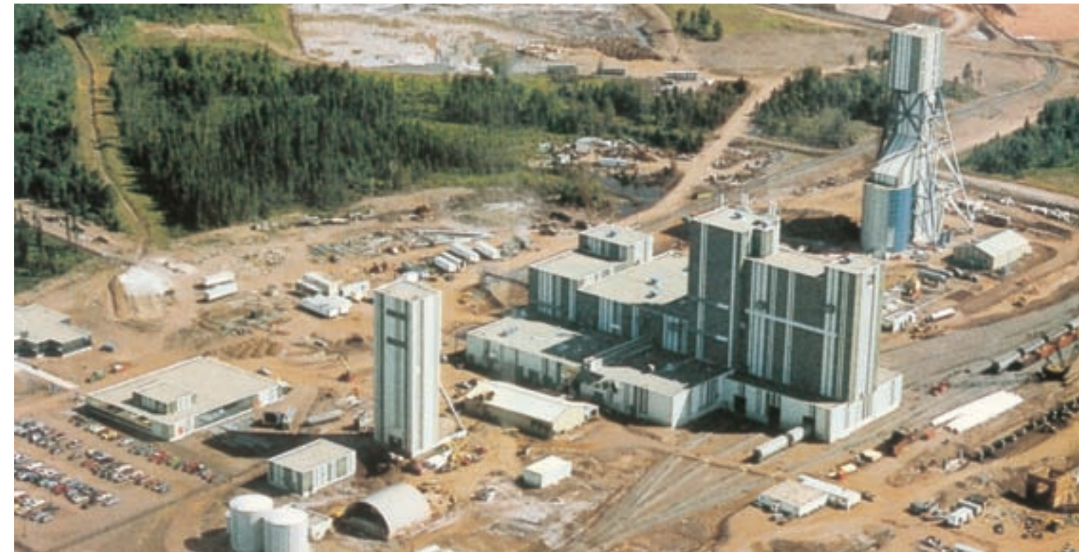
Das Kaliwerk der Denison-Potash Company (DPPC) in New Brunswick kurz vor der Fertigstellung im Jahr 1985
