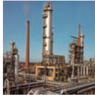
Die Wintershall-Raffinerie Salzburg im Jahr 1969
