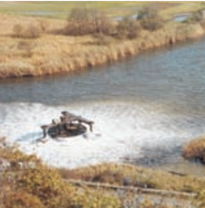
von links nach rechts Sauerstoff-Anreicherung der Werra. Das Abwasser der Werke wird mit dem Flusswasser vermischt und dabei mit Sauerstoff angereichert.
