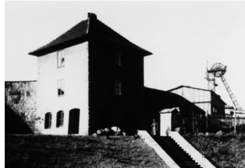
Bewachter Eingang zur Heeresmunitionsanstalt Volpriehausen auf dem Gelände des ehemaligen Kaliwerkes Wittekind-Hildasglück in der Nähe von Uslar (Solling)
