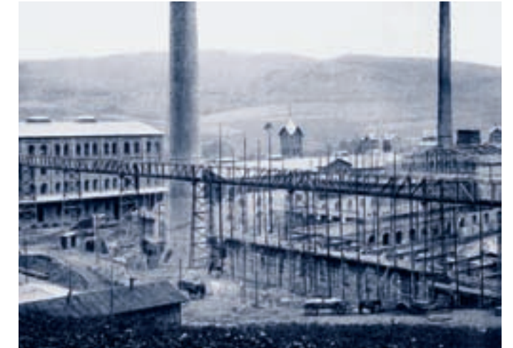
Ansicht des Kaliwerkes Salzdetfurth in der Gründungsphase
