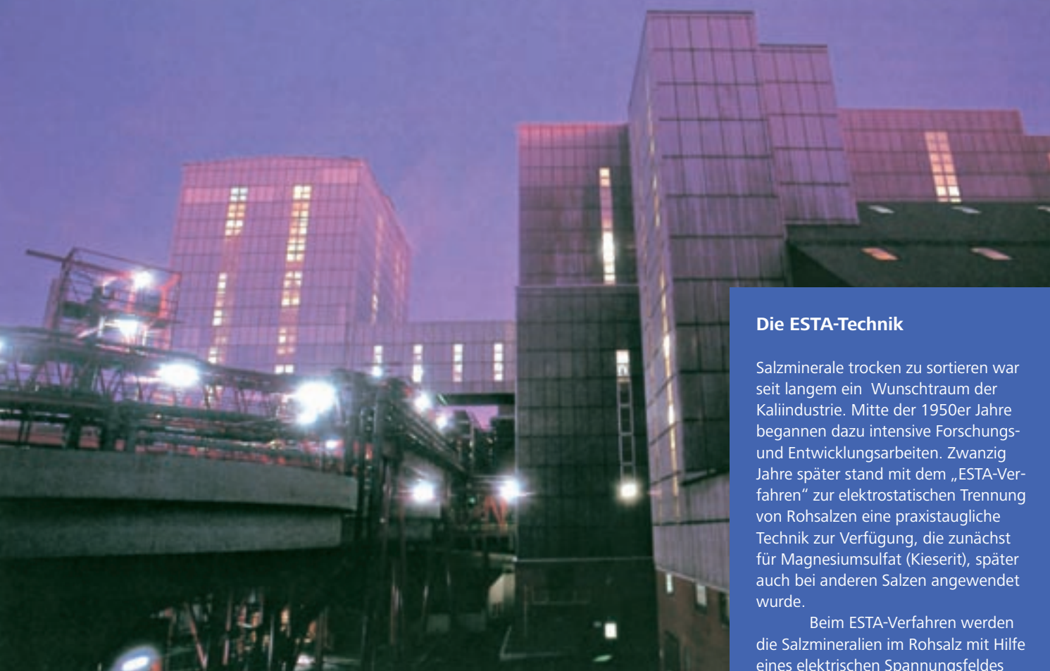
Die ESTA-Großanlage im Kaliwerk Hattorf sortiert mehr als 1.000 Tonnen Rohsalz pro Stunde in die einzelnen Mineralienbestandteile (Bild 1988).
