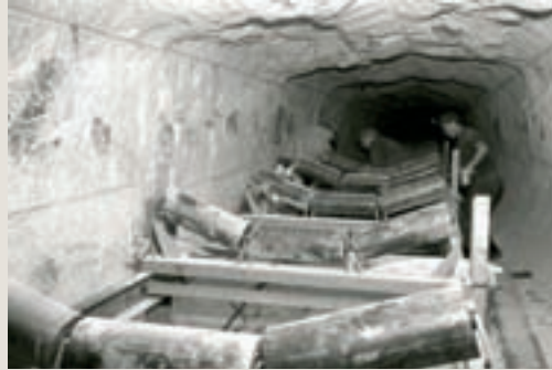
links Die Bandförderung löst ab 1955 den Gleisbetrieb ab (im Bild: Montage einer Bandanlage in Hattorf).
