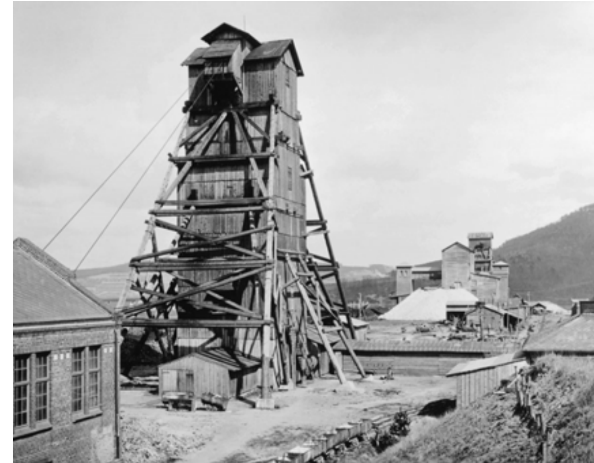
Die 1894 gegründete Gewerkschaft Kaiseroda teufte 1911 gleich zwei Schächte, Kaiseroda II und III (siehe Bild), aus denen später das Werk Merkers hervorging. Der Schacht Kaiseroda I war bereits seit 1900 in Betrieb und gehörte zu den ersten Kalischächten des Werra-Fulda-Reviers.
