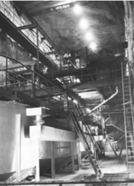
links Untertägige Flotationsanlage im Steinsalzwerk Riedel (Burbach-Kaliwerke AG); 1956 wurde die Anlage wieder stillgelegt.
