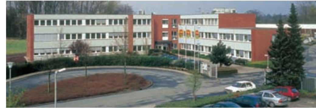
Im März 2001 konnte die COMPO auf dem Gelände in Münster-Handorf einen Erweiterungsbau (links) des Verwaltungsgebäudes beziehen.
