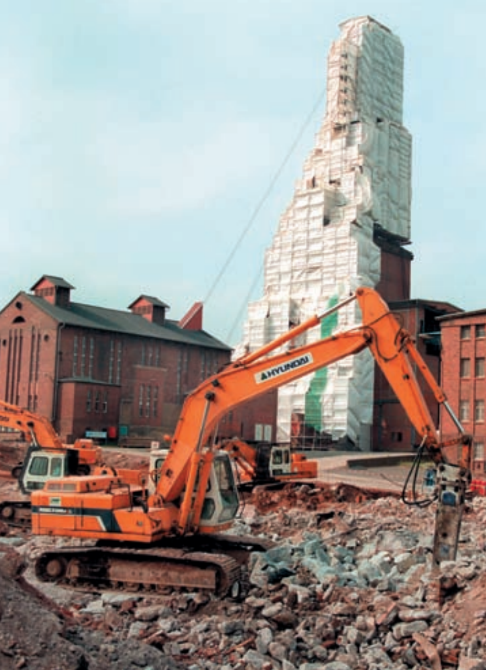
Auf dem Gelände des Kaliwerkes in Merkers wurden die Fabrikanlagen abgerissen. Im Hintergrund ist der verpackte Förderturm zu sehen, der für die Seilfahrt der Verwahrungsmannschaft und das Erlebnis Bergwerk Merkers saniert und erhalten wurde.
