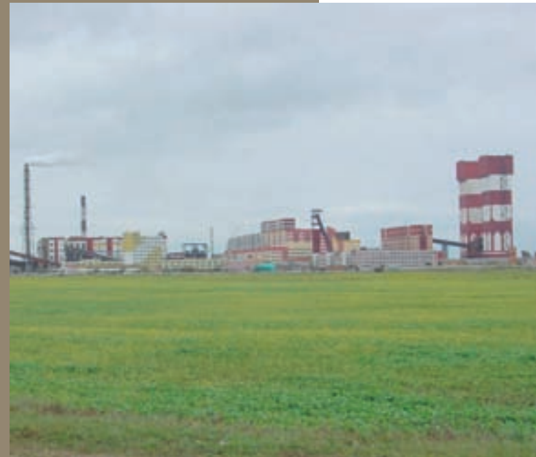
Die Übertageanlagen des Kaliwerkes Soligorsk IV der weißrussischen Belaruskali
