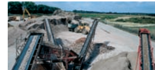
Anlage zum Recycling von Baustoffen in Sehnde östlich von Hannover
