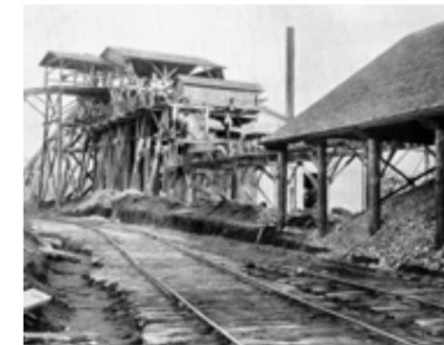
im Kasten Ein Schritt zur Gewinnung von Thomasmehl: die Zerkleinerung der Thomasschlacke im Stampfwerk
